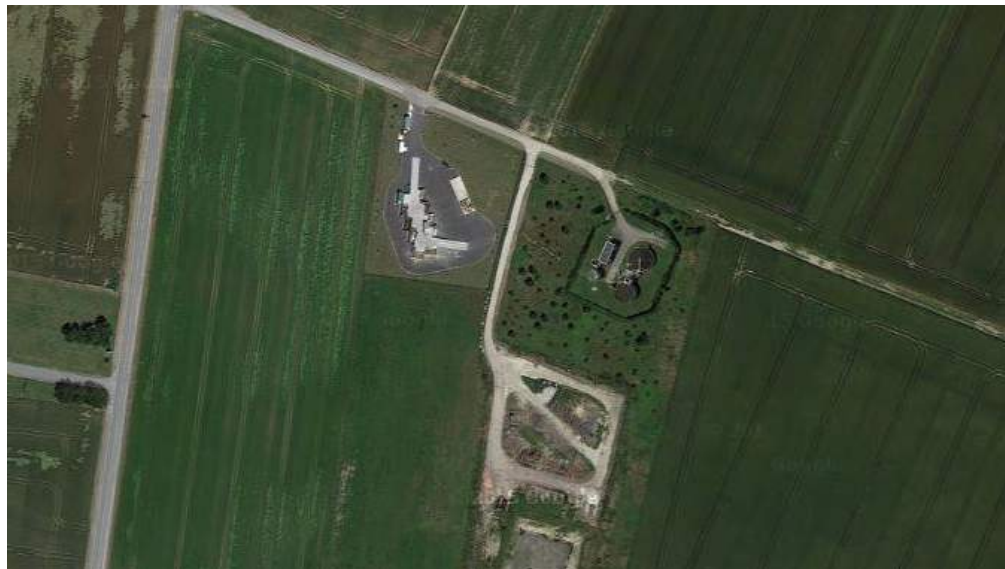
Localisation station d'épuration de Méré
